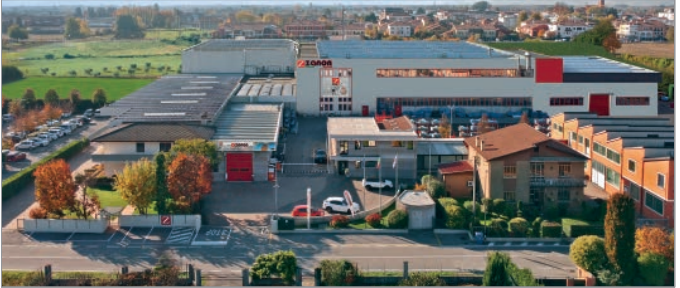
HEADQUARTERS CAMPODARSEGO Sede centrale di Campodarsego (via Madonnetta, 30)
